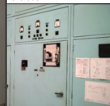
À gauche, vue sur le TGBT après rénovation
