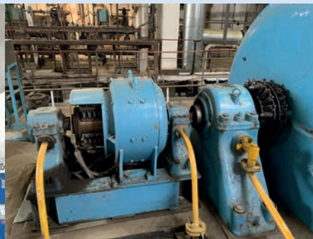
Turboalternateur de l'usine de Kaminski ayant un problème d'excitation
